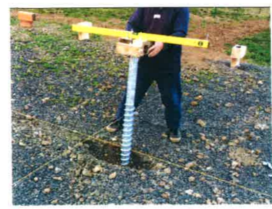
Detaliu fundatie de tip Krinner-surub de tip M
